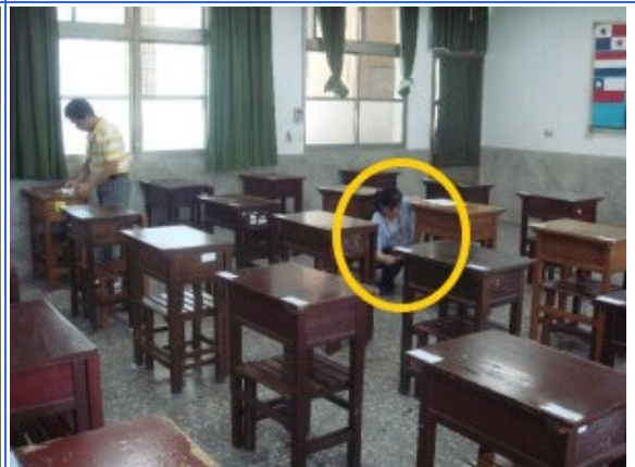
【圖4】6/30虎尾高中分區~工作人員仔細檢查每張桌椅，並將白紙墊在有輕微搖晃情形的桌腳。
